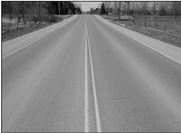
Figure 8a. Hot Mix
